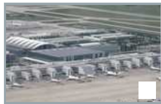
Vorfeld mit Terminal 2 und MAC
